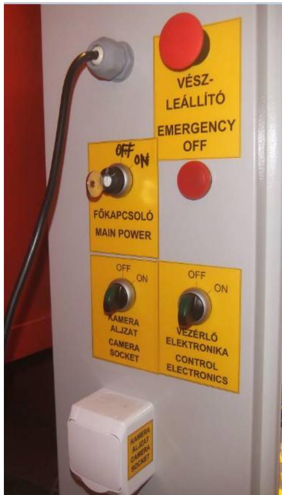
66. ábra Vészleállító és az egyes részegységeket indító kapcsolók
