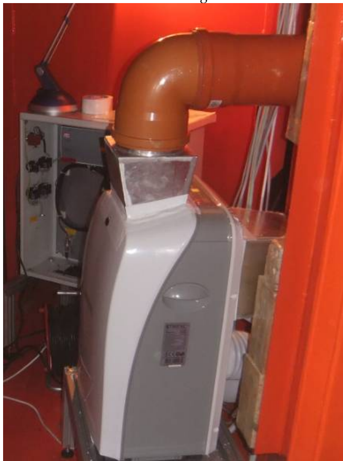
61. ábra A mobilklíma a végső helyén a mérőszoba melletti szobában, látszik a légvezetést biztosító alkatrészek is
